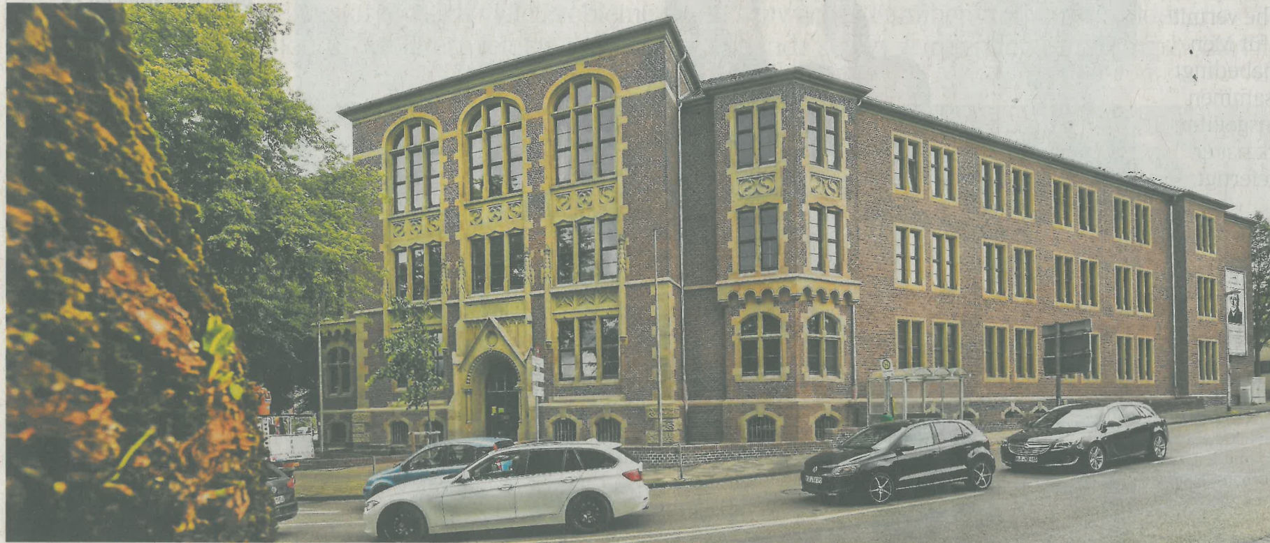
Der Altbau des Gymnasiums an der Römerstraße ist von den Gerüsten befreit: Die Sanierung der Fassaden ist abgeschlossen. RP-FOTO: GOTTFRIED EVERS
